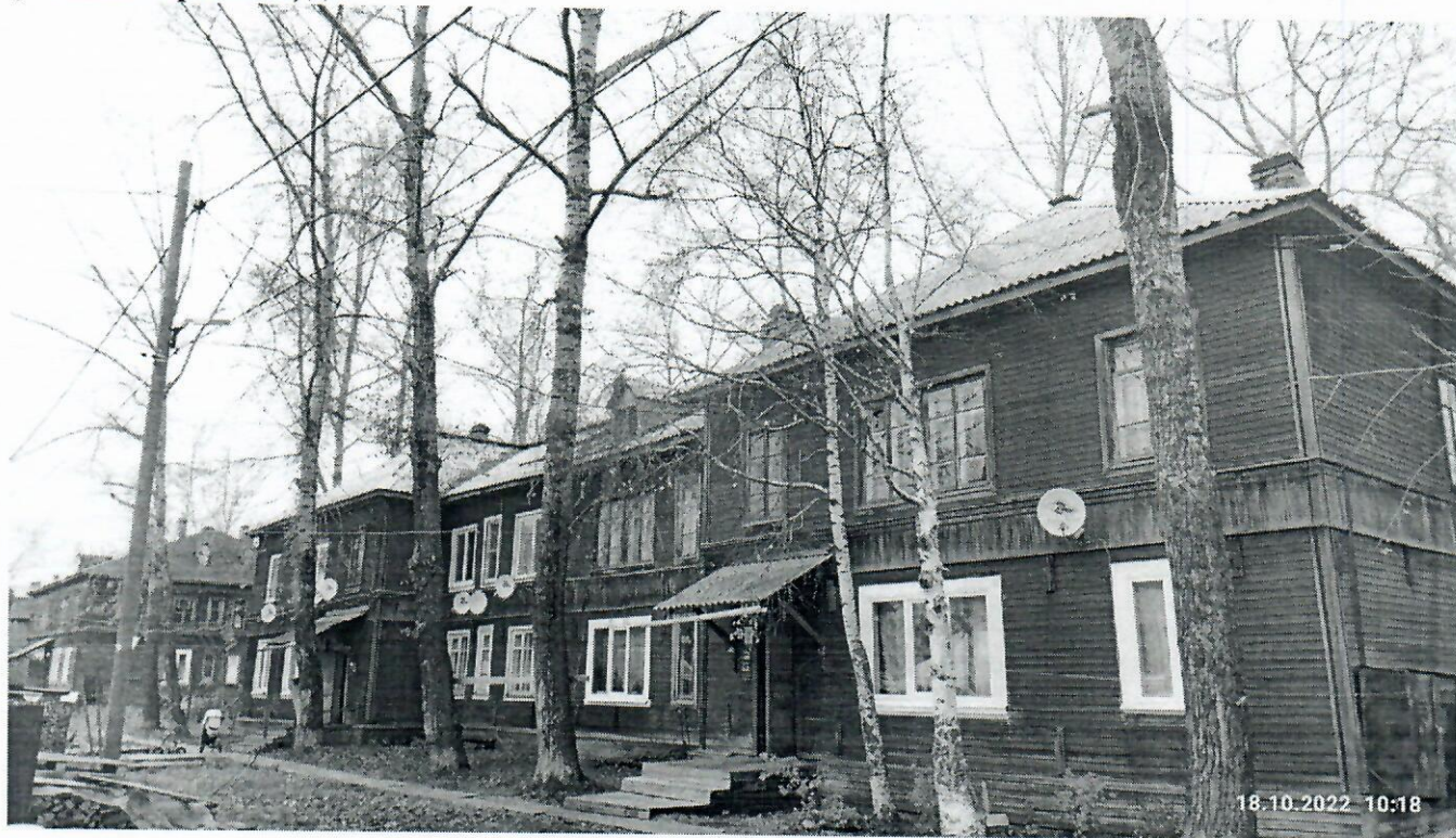
ул. Левобережная, д.3
